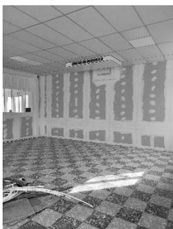
• A la cantine, les murs ont également été isolés avec soin pour renforcer l'efficacité énergétique globale du bâtiment. Une enveloppe thermique performante permet de limiter les échanges de chaleur avec l'extérieur, garantissant ainsi une température intérieure stable et agréable tout au long de l'année.
