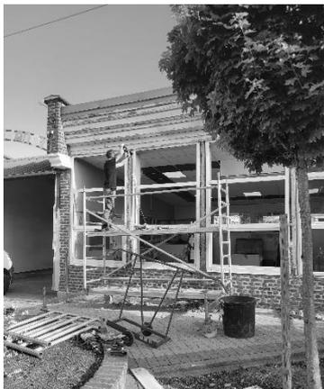
• Les ouvrants, tels que les fenêtres et les portes, ont également été remplacés par des modèles plus performants sur le plan énergétique. Grâce à des vitrages isolants et des matériaux modernes, les déperditions thermiques seront limitées, permettant ainsi de conserver la température intérieure plus stable et de réduire l'usage du chauffage et de la climatisation.
